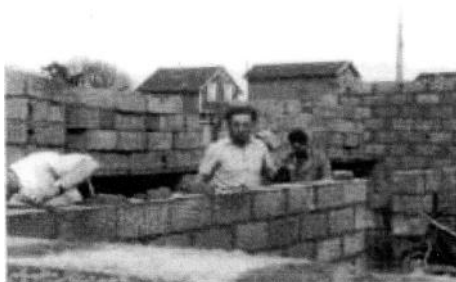
Montage des murs
