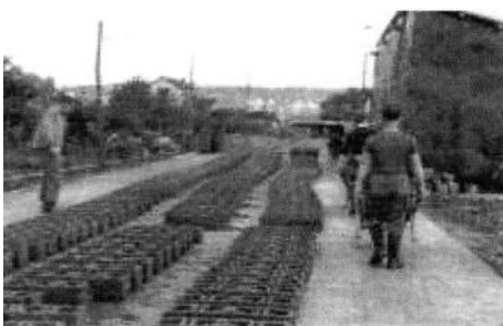
Fabrication des parpaings
